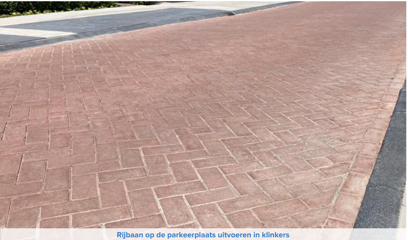
Rijbaan op de parkeerplaats uitvoeren in klinkers
