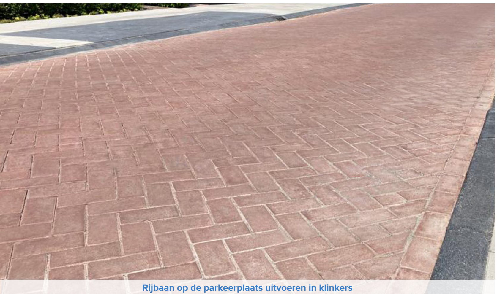
Rijbaan op de parkeerplaats uitvoeren in klinkers
